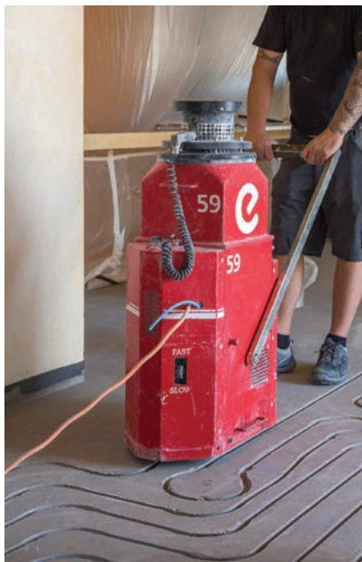
Fresatura su pavimentazione preesistente
